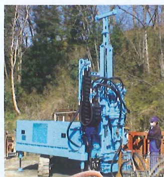
SP-8000現場掘削状況
