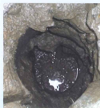
礫・玉石掘削状況
